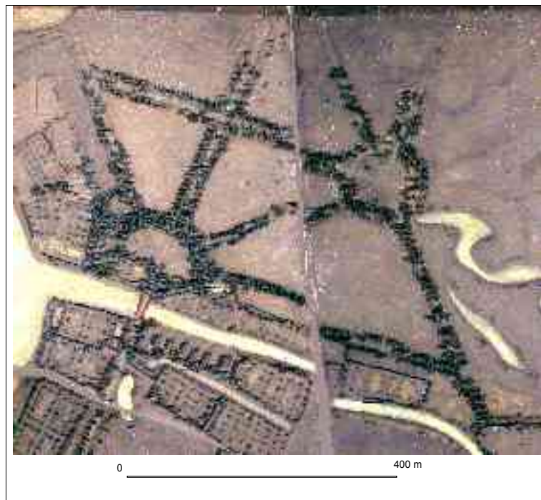
Figure 21?, Orangerie et chantier naval
