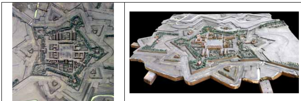
Figure 32, Citadelle, avant nettoyage à gauche, vue aérienne, après, vue basse oblique
