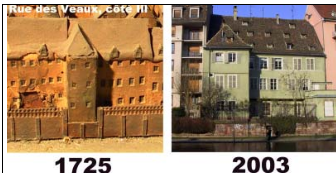
87. Quai de l'Ill, arrière de la rue des Veaux : maison à avant-corps, niveaux et travées conformes à la maison actuelle conservée
