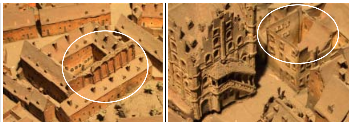
124. Exemples de bâtisses en cours d'abandon, murs sans charpente de Saint-Nicolas-aux-Ondes, à gauche, et toit effondré de la chancellerie incendiée en 1686, à droite
