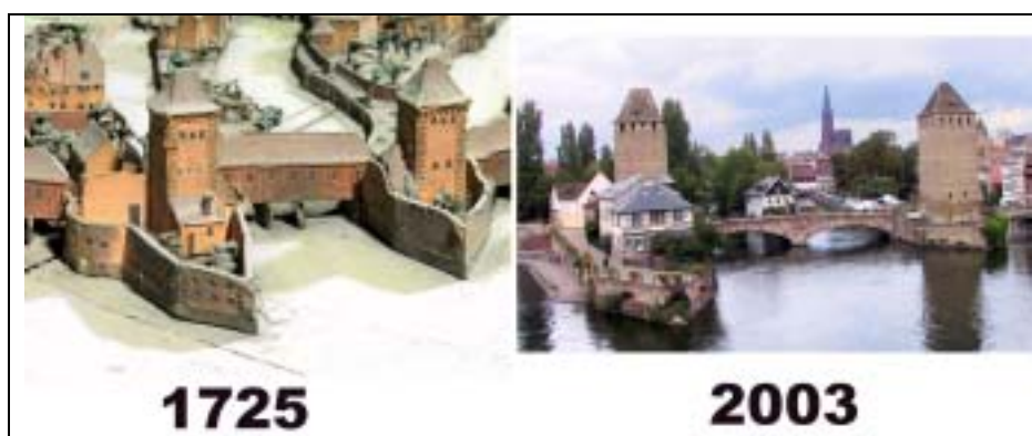
136. Les Ponts Couverts, 1725, 2003
