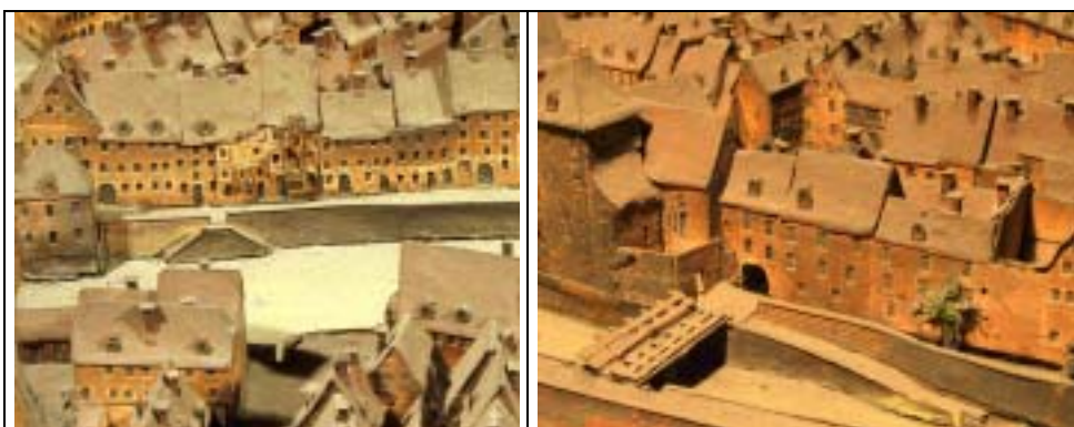
125. Quais de l'Ill, accès à l'eau attestés sur le plan Blondel, quai Saint-Nicolas et Porte des Juifs
